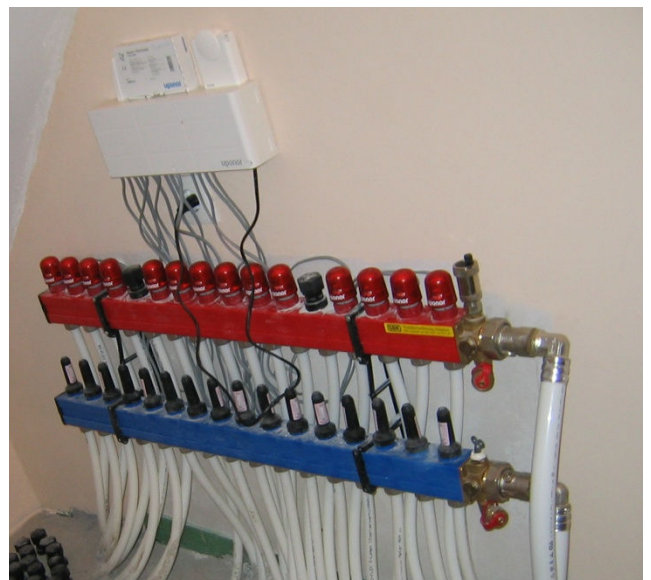
ZLTV vloerverwarming met draadloze ruimtetemperatuur-naregeling voor slaapvertrekken
